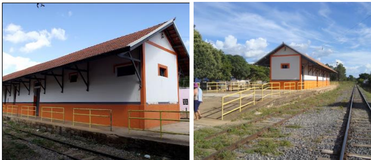
Figura 133: Estação ferroviária desativada e seus trilhos, no município de Buenópolis-MG. Foto: Timothy Becher.
