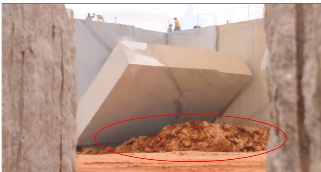
**Figura 13:** Exemplificação de colchão de terra utilizado para amortecer a queda da bancada. Fonte: Google Imagens.
