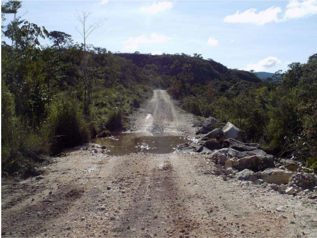
Figura 116: condições de acesso.
