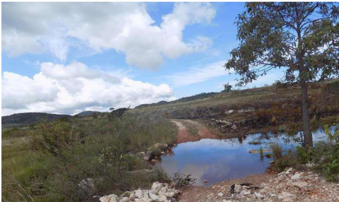
Figura 117: condições de acesso.
