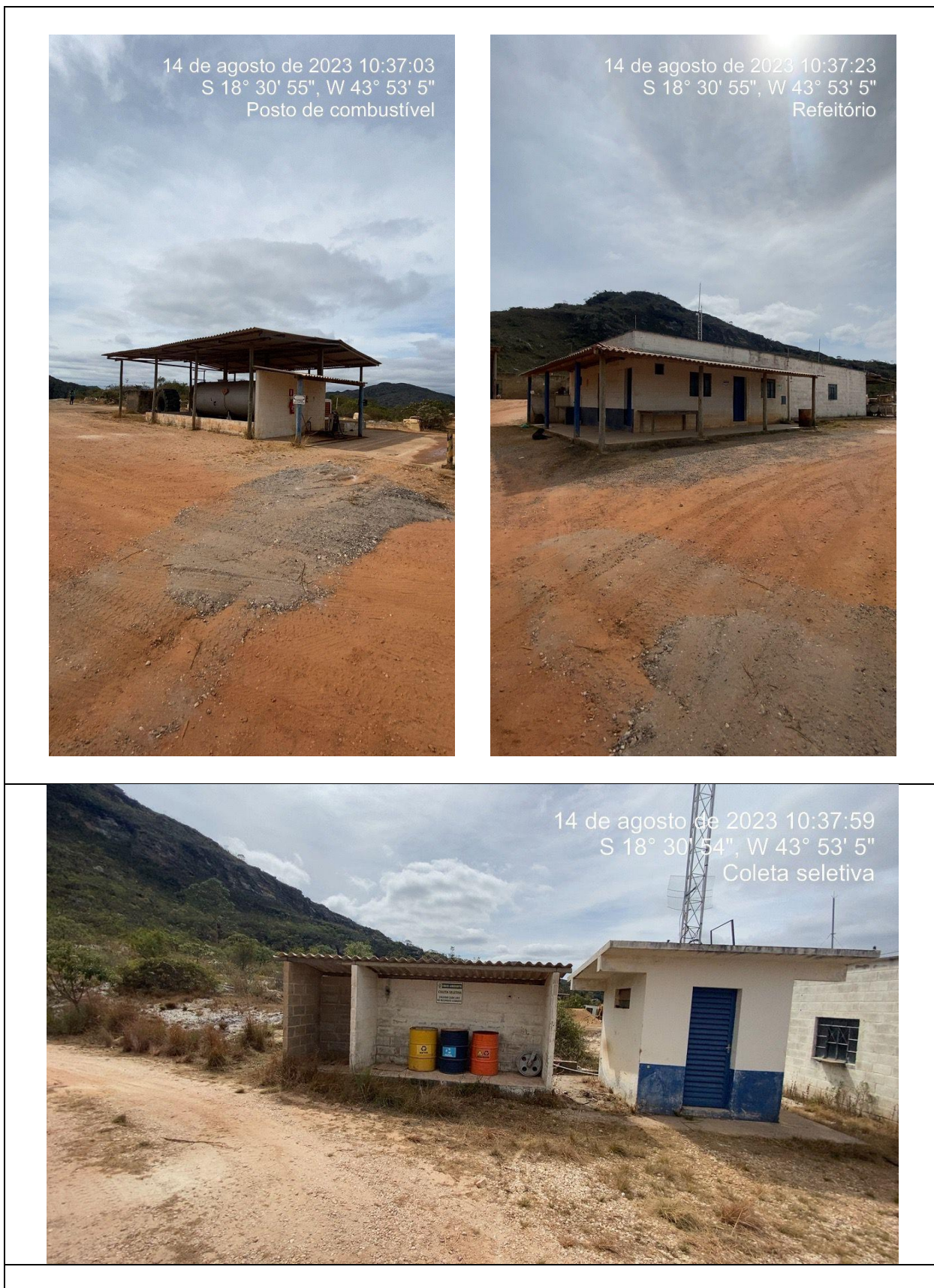
Figura 39: Área de Infraestrutura de apoio do empreendimento.
