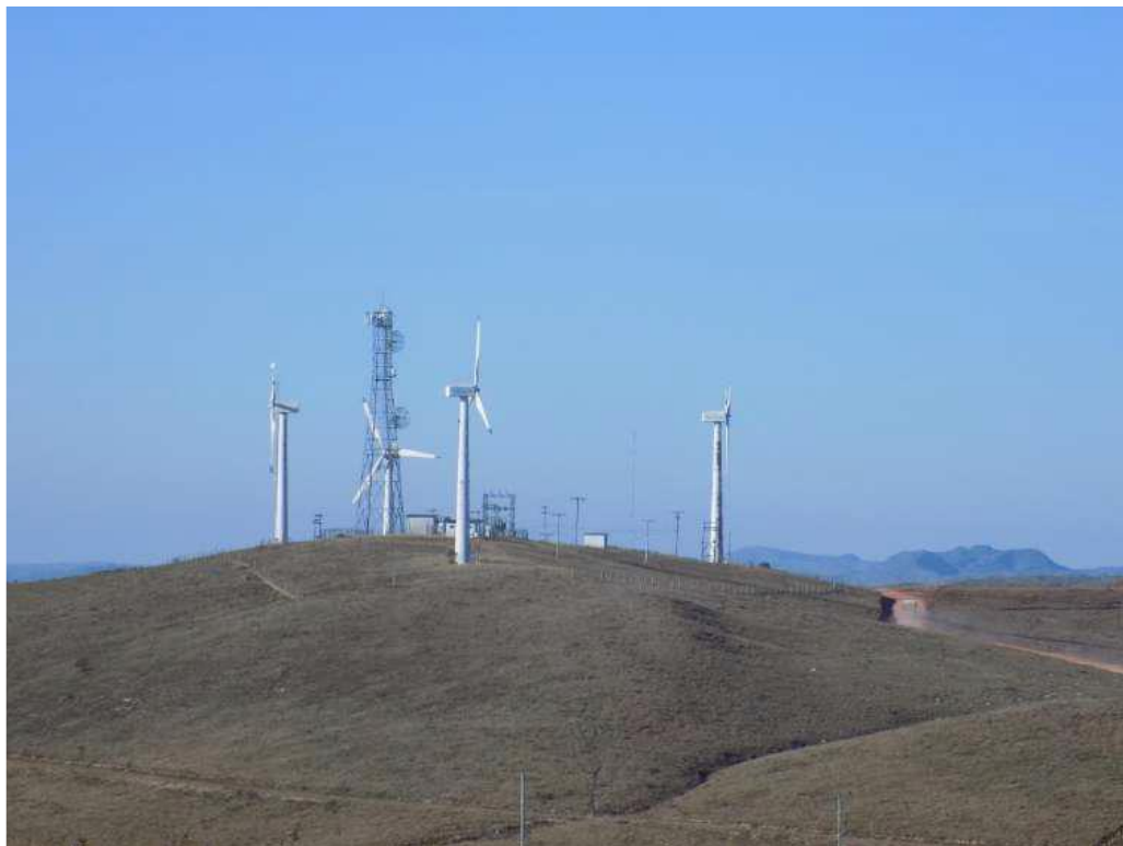
Figura 42: Parque Eólico Morro do Camelinho pertencente a Companhia Energética de Minas Gerais – CEMIG.
