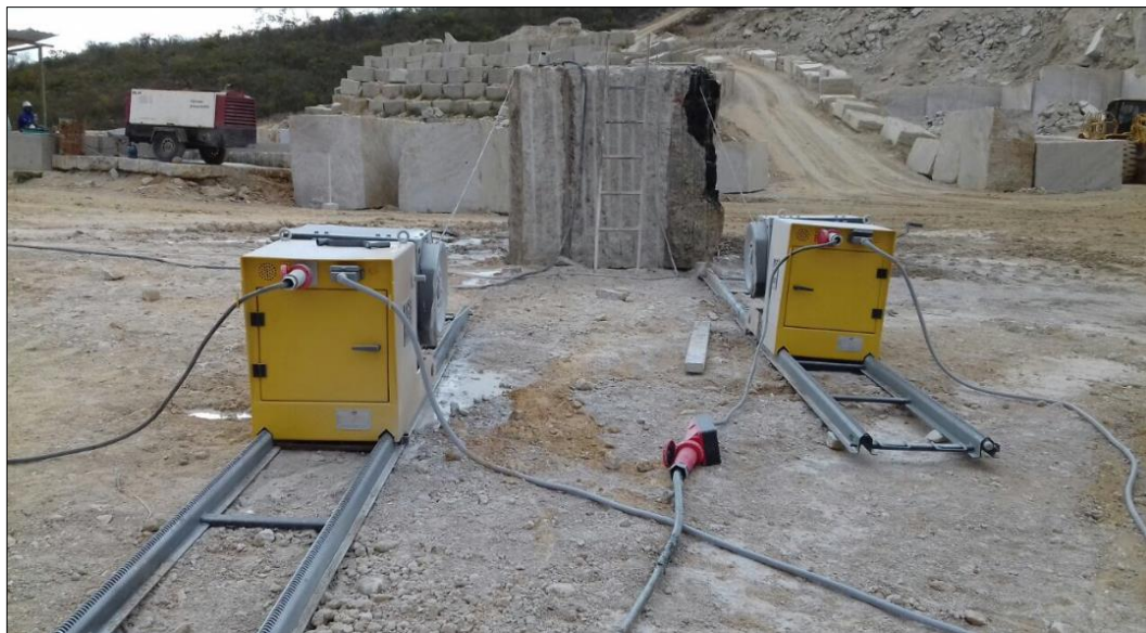
c) Máquina à Fio Diamantado em funcionamento.
